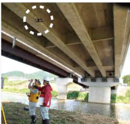
ドローンによる点検の様子
